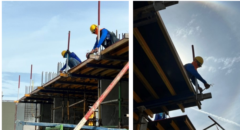
ภาพที่ 4-30 ติดตั้งนั่งร้านและสวมใส่อุปกรณ์ป้องกันภัยส่วนบุคคล
