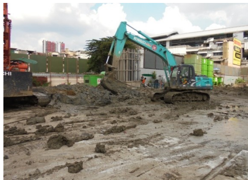
ภาพที่ 4-9 ตักดินส่วนเกินและขนส่งออกจากพื้นที่โครงการไม่เก็บไว้ภายในโครงการ
