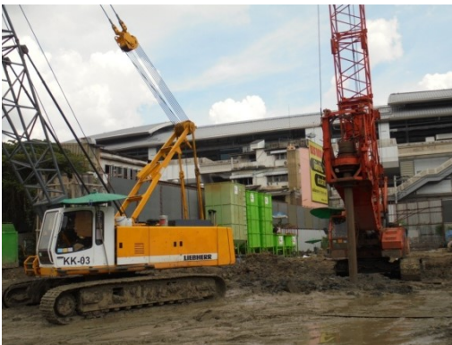
ภาพที่ 4-6 การก่อสร้างเสาเข็มแบบเจาะ โดยใช้แบบเจาะเปียกใช้สารเบนโทไนท์
