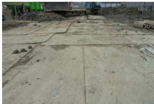
ภาพที่ 4-7 ปูแผ่นเหล็กหนาไว้เป็นทางวิ่งรถ
