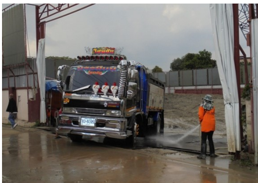
ภาพที่ 4-8 ล้างล้อรถบรรทุกด้วยสายฉีดแรงดันสูงก่อนออกจากโครงการ
