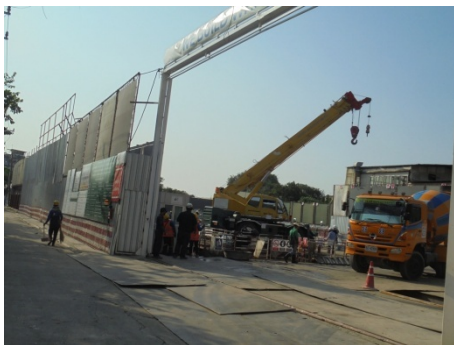
ภาพที่ 4-7 ปูแผ่นเหล็กหนาไว้เป็นทางวิ่งรถ
