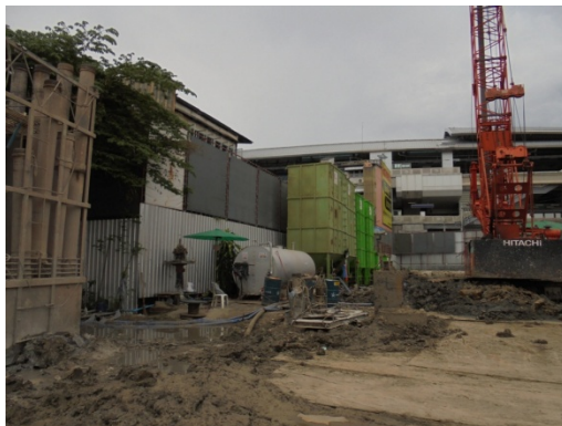
ภาพที่ 4-6 การก่อสร้างเสาเข็มแบบเจาะ โดยใช้แบบเจาะเปียกใช้สารเบนโทไนท์
