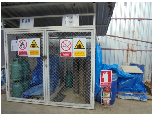
ภาพที่ 4-24 ติดตั้งถังดับเพลิงเคมีบริเวณที่เก็บถังก๊าซ
