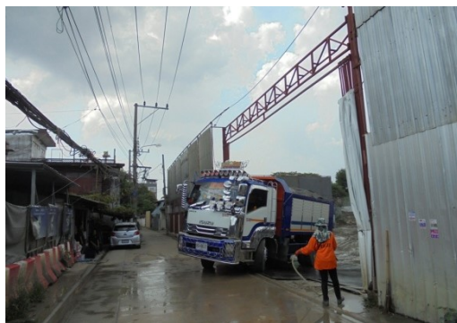
ภาพที่ 4-8 ล้างล้อรถบรรทุกด้วยสายฉีดแรงดันสูงก่อนออกจากโครงการ
